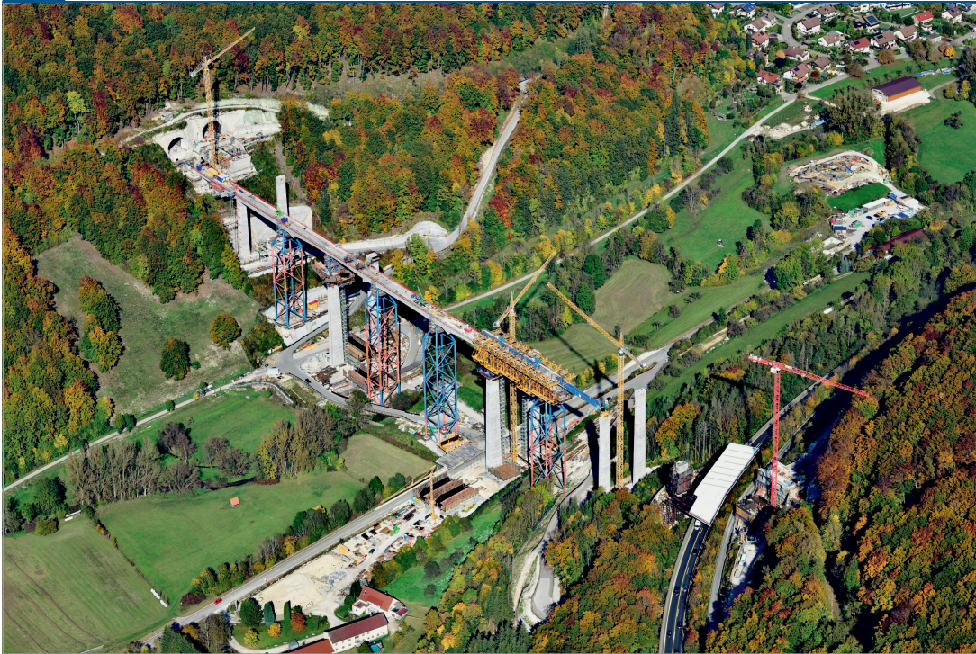
Die Filstalbrücke auf der Neubaustrecke Wendlingen–Ulm überquert bei Wiesensteig auf zwei eingleisigen Brücken (485 m und 472 m) das Filstal.
