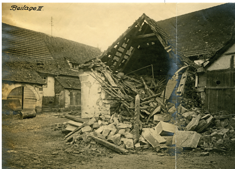
Bild 2: Zerstörte Brennerei nach einer Kesselexplosion in Kleinheppach im Remstal im Jahre 1906 Copyright: TÜV Süd
